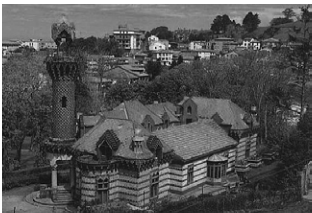
2. Vista general de El Capricho desde el ángulo SO, antes de la restauración de 1989.
