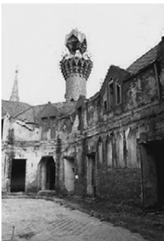
6. Restauración de 1989. Estado de la fachada sur una vez desmontado el añadido.
