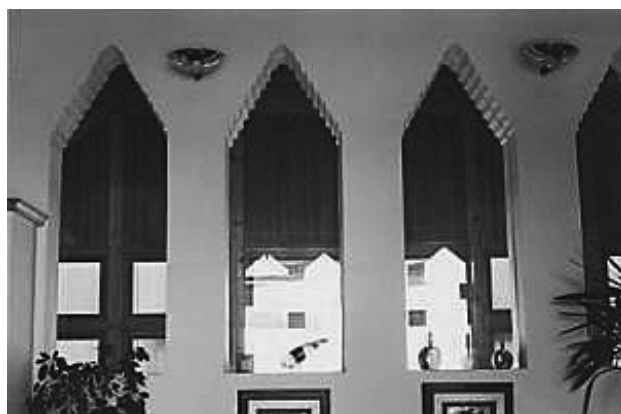
20. Arcos que comunican la salona con el corredor y el invernadero.
