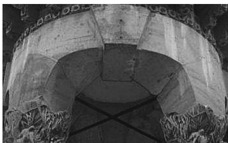
49 y 50. Estructura de cierre del porche de El Capricho , vista desde el exterior y desde el interior.
