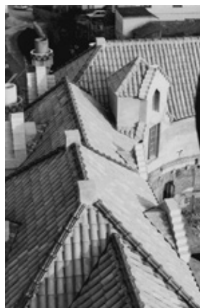
11. Vista de los caballetes de El Capricho durante el proceso de restauración.
