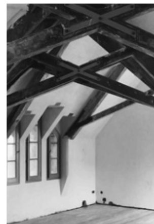
12. Interior de la planta de desvanes con el sistema de pares en forma de aspa.
