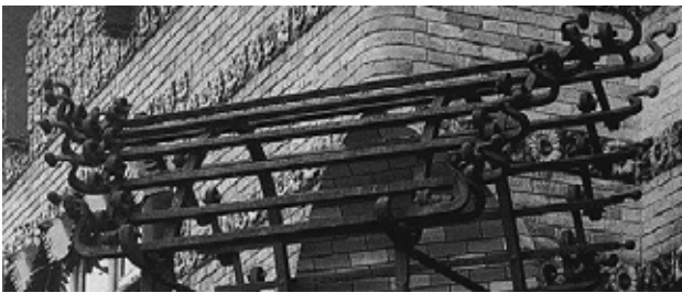
60. Detalles de la forja con látigos y bolas de los balcones angulares de El Capricho .
