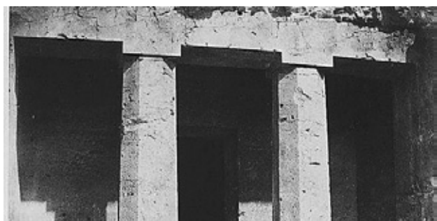
52. Detalle de uno de los pórticos de las tumbas de Beni-Hassan con los pilares monolíticos.
