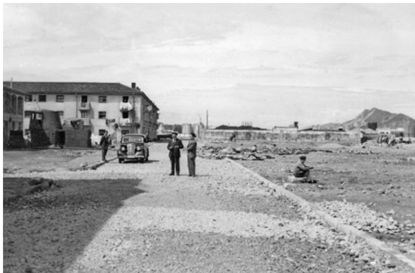
Obras del poblado de pescadores, ca. 1950. Archivo de la Autoridad Portuaria de Santander.
