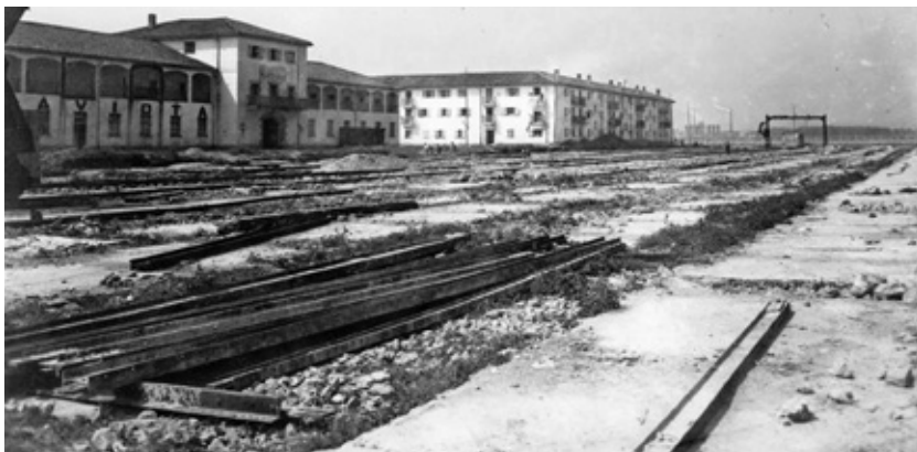
Solares de la Avda. Sotileza durante obras de relleno.
