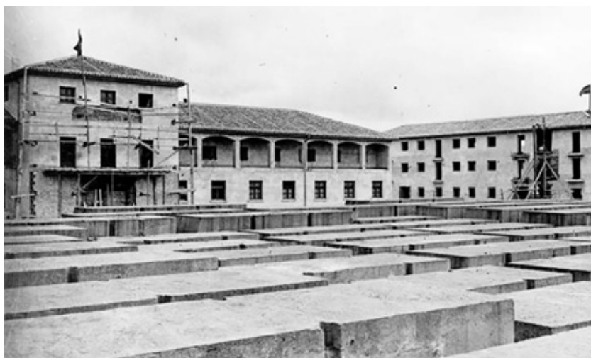
Casa del Pescador en su fachada hacia la Dársena de Maliaño.
