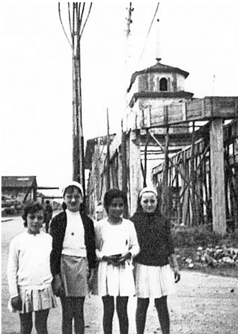
Construcción del colegio Miguel Bravo, año 1969.
