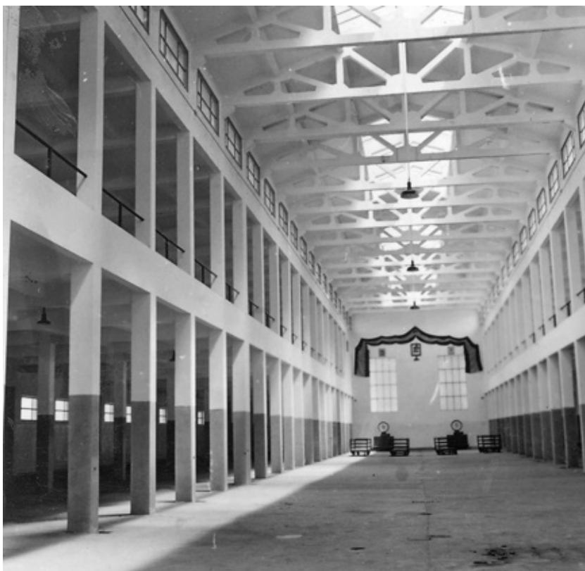
Espacio interior de la antigua Lonja del pescado de Santander.
