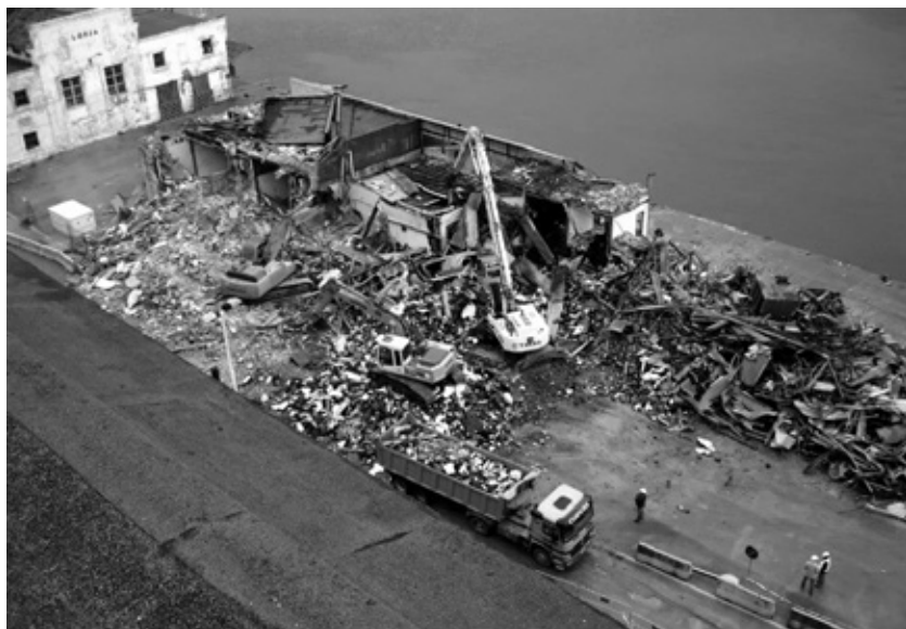
Derribo de la antigua Fábrica de hielo situada en el muelle.
