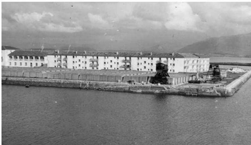
Vistas del Barrio Pesquero en construcción, ca. 1950.
