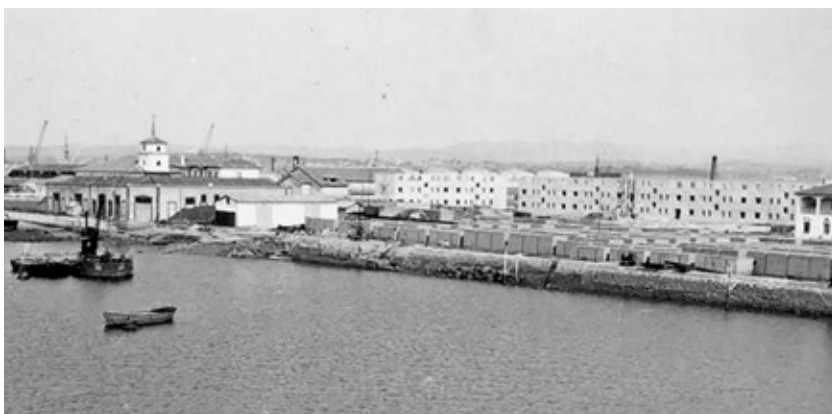
Vista del Poblado de Pescadores en construcción, hacia 1950.
