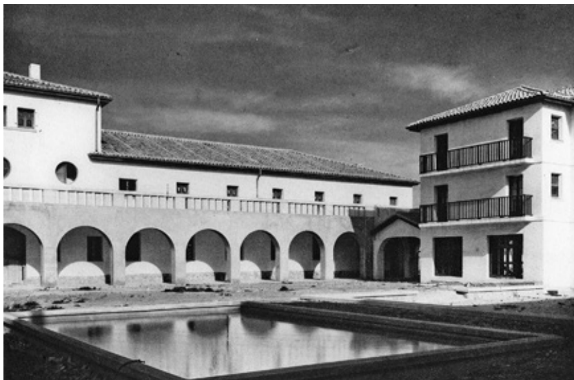
Casa del Pescador y Plaza de los Cabildos en construcción.
