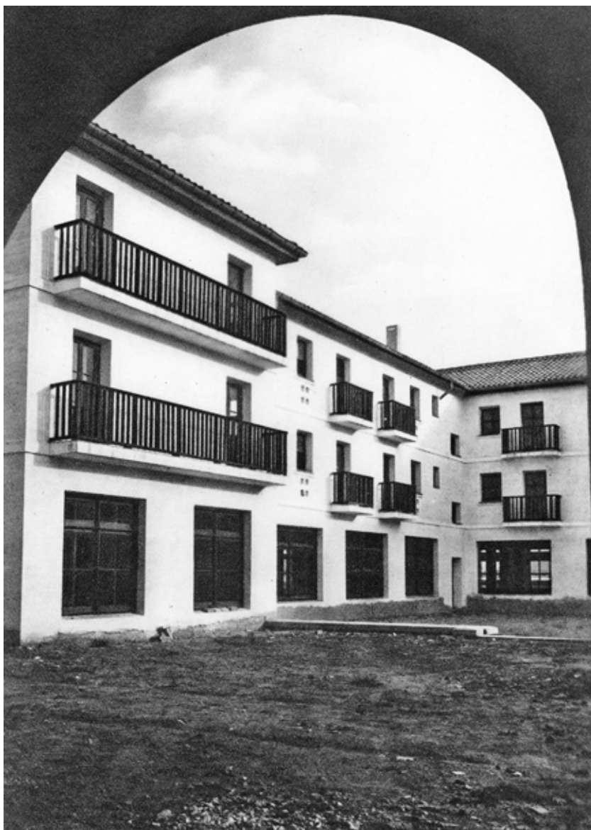
Plaza de los Cabildos en construcción.
