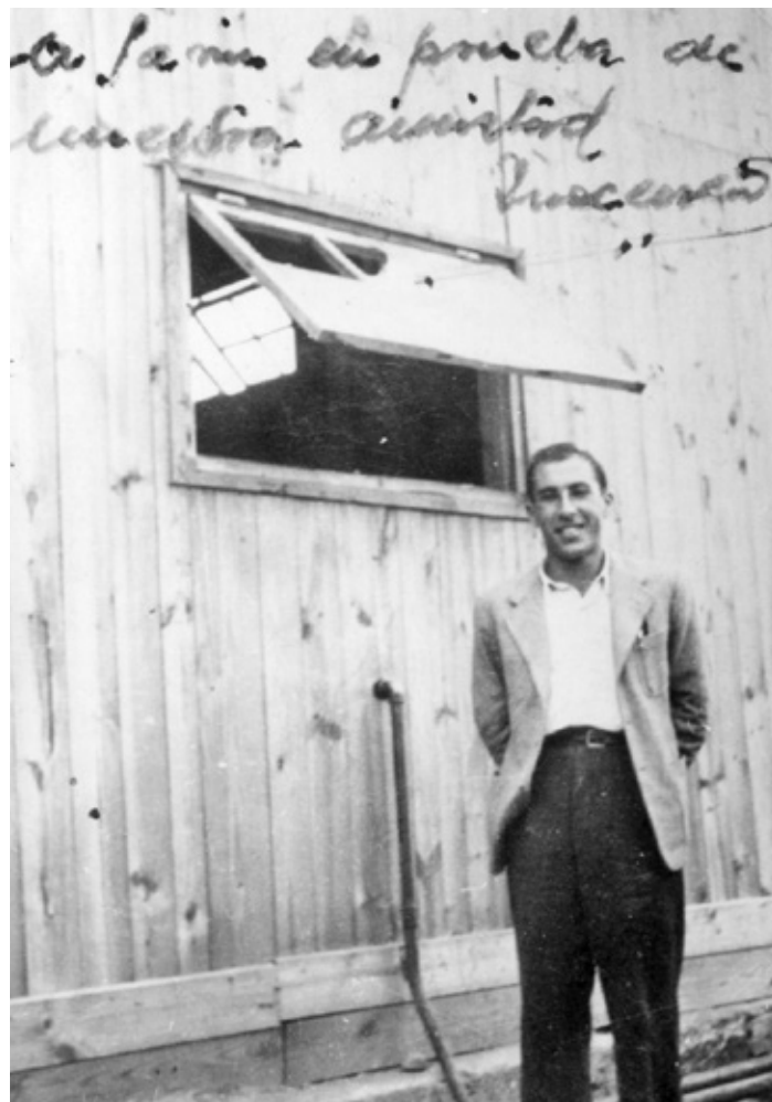
Inocencio Aja “El Vasco” delante de un barracón en el Destacamento Penal de SNIACE, destinado a la construcción de la fábrica en Torrelavega. Foto cedida por Rosario Ruiz, con dedicatoria y firma de Aja.
